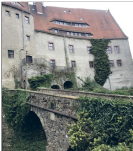
Zugang von der Nordseite zum Schloss Reinsberg
